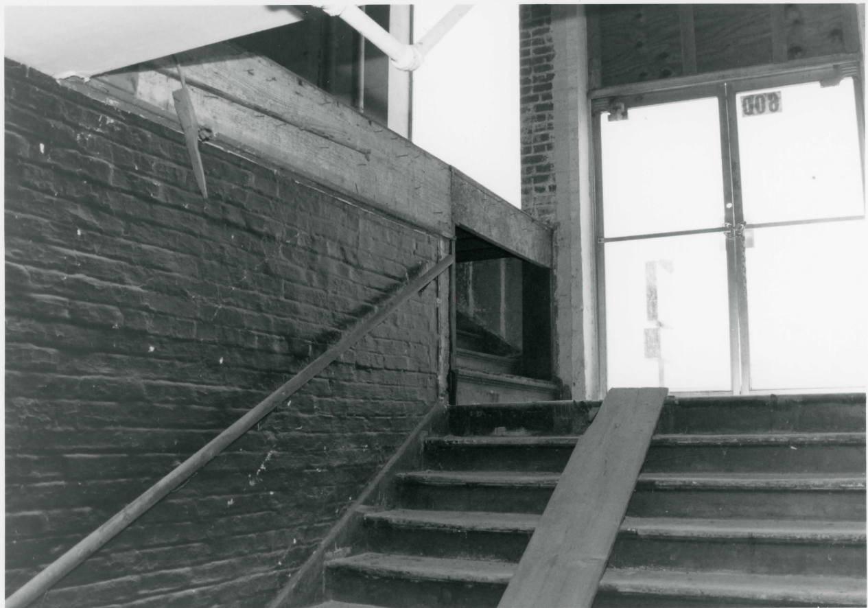
D. M. Oberman Mfg. Co. 600 Bonville Avenue Springfield, Greene Co., Mo Photo 13
